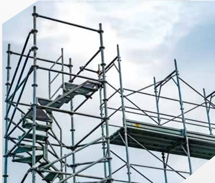
السقالات والأبواب والنوافذ Scaffolding, Doors, and Windows
